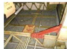
建屋内の筋交による補強
